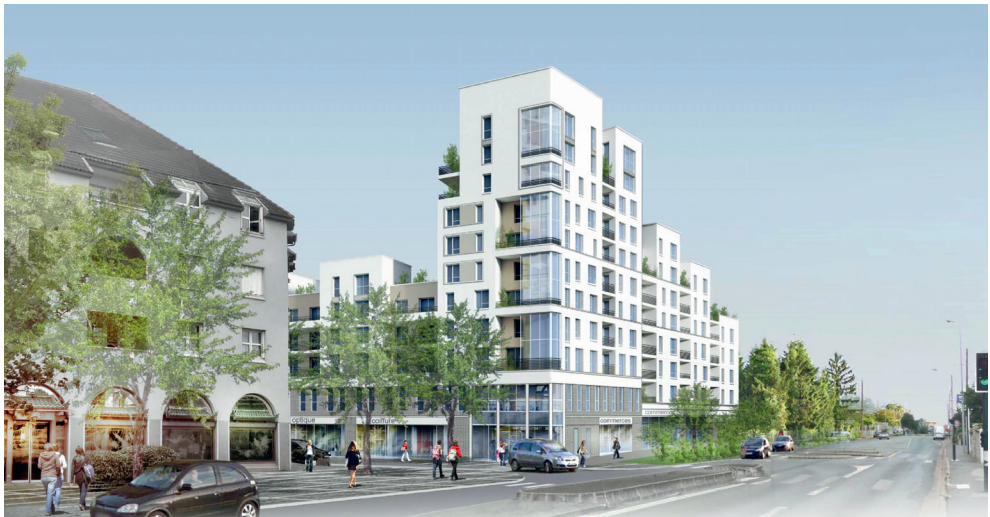
Quartier de la gare à Montigny-lès-Cormeilles - Vue depuis l'avenue de la Libération © Codif 2020
